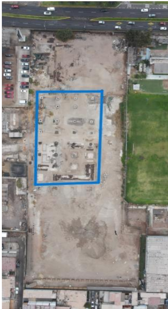
Foto1.- Vista general del area donde se emplazan las fundaciones existentes.
