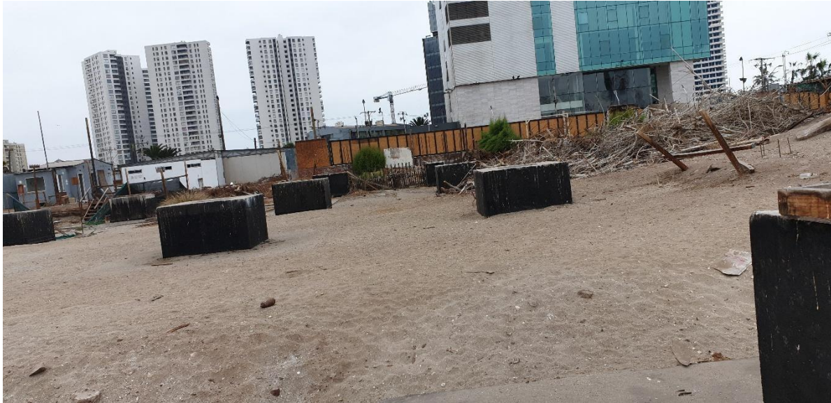
Foto 2.- Vista dados de fundación terminados.
